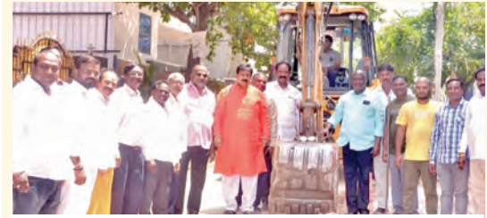
రోడ్డు పనులకు శుభాస్థాపన చేస్తున్న కార్పొరేటర్
